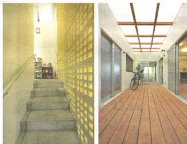
右/子世帯は、このデッキテラスを囲むようにして居室を配置。家族が別の部屋で過ごしていても、その様子はデッキテラスを介して伝わってきます。左/親子世帯をつなげる階段室の前面道路側には花ブロックを設置。光や風を程よく通しながら、外観のアクセントにもなっています。
