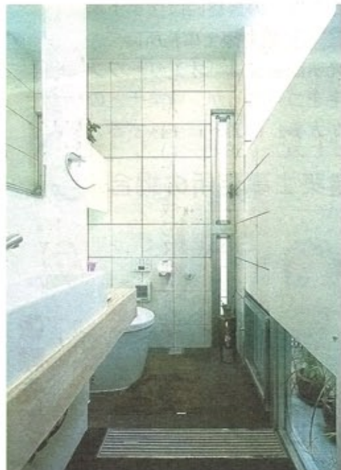
高窓からの光で明るいトイレ。右手の地窓からは坪庭が見える。グレーチングで床はフラットにした
